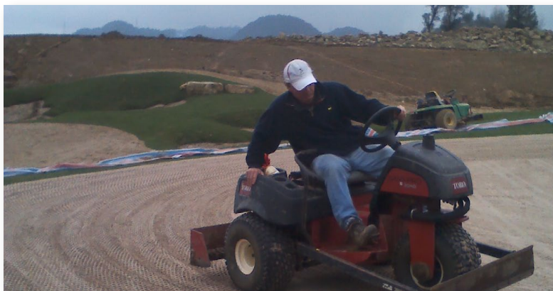
Flagstick项目经理Jason Burt在保利公园2010项目向现场工作人员示范如何在果岭播种前松表面
