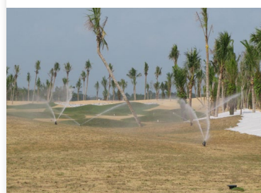
上图：特征区造型师Dale Menning在12号果岭上工作 下图：灌溉系统已安装并投入使用，植草紧随其后 左下图：Flagstick队员Tim Zirkle和Vicky Shi结束了一整天现场的工作
