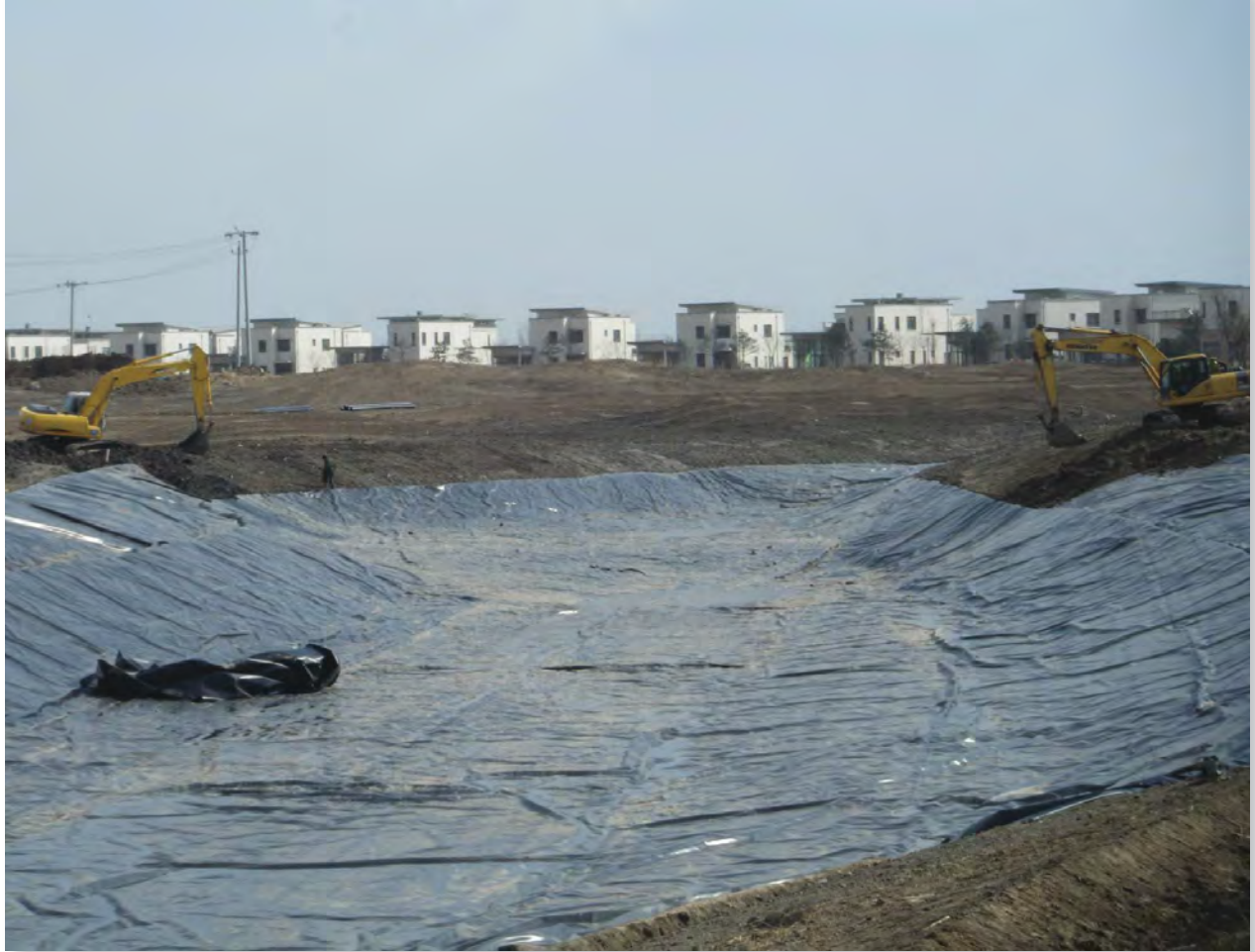
在近期的改造过程中，为了尝试减慢盐分流失到钠含量已经较大的喷灌水中的速度，龙海国际高尔夫乡村俱乐部在球场池塘安装了重负载的衬垫。照片承蒙 Flagstick 高尔夫球场建造管理公司提供
