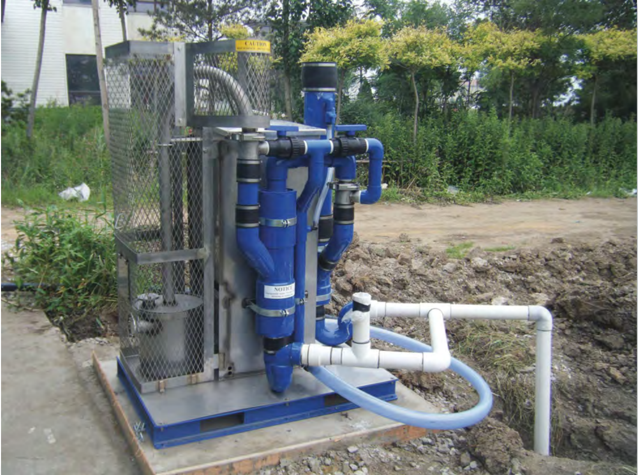
燃硫装置相对简单，常常设在喷灌池的旁边，它会在水返回喷灌池之前将其与二氧化硫气体混合，来平衡钠含量较高的水。照片承蒙 Troon Golf Asia-Pacific 提供
